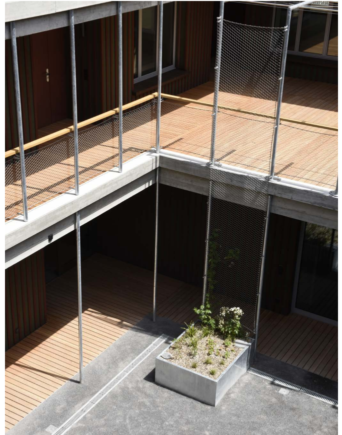
Abb. 10: Terrassen und Laubengänge mit Holzrost.
