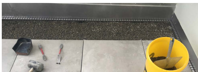
Abb. 5: Verlegung der Keramik-/Feinsteinzeugplatten in Bettungsschicht aus Rundkies.
