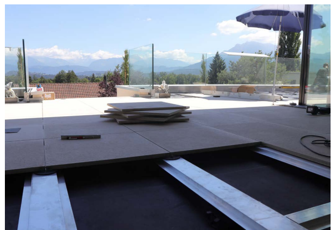
Abb. 7: Verlegung der Keramik-/Feinsteinzeugplatten auf Schienensystem.
